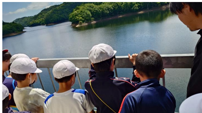
取水口の見学（金木小学校）
