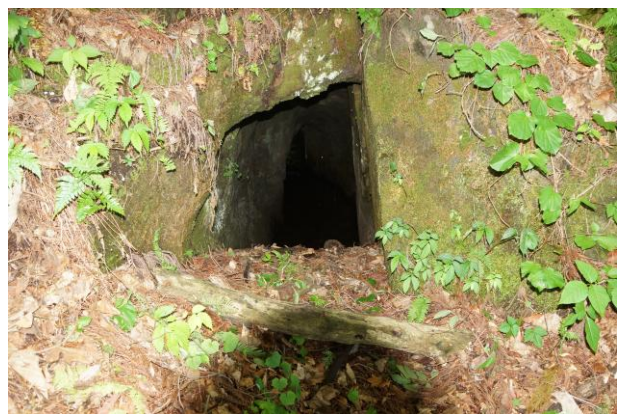
【暗渠手掘り跡】
