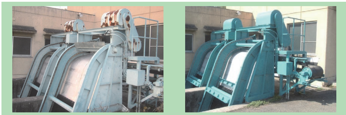
除塵装置の分解補修、塗装
