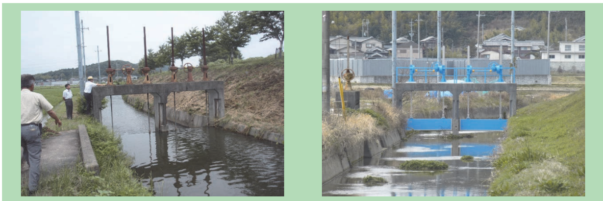
巻上機の整備補修
