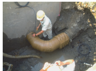
管水路（漏水箇所）の補修
