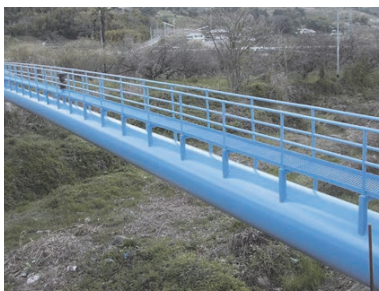
管水路（水管橋）の補修・塗装
