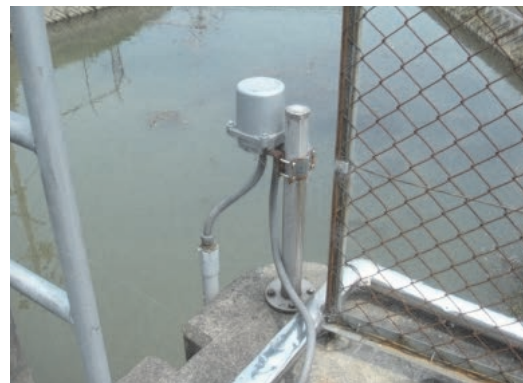
水位計測器の更新
