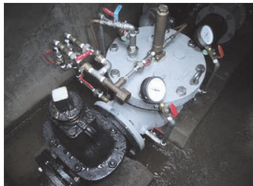
減圧弁の補修
