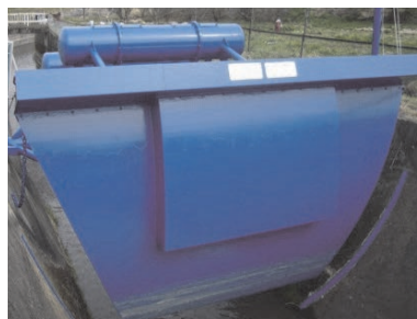
分土工（水位調整ゲート）の塗装
