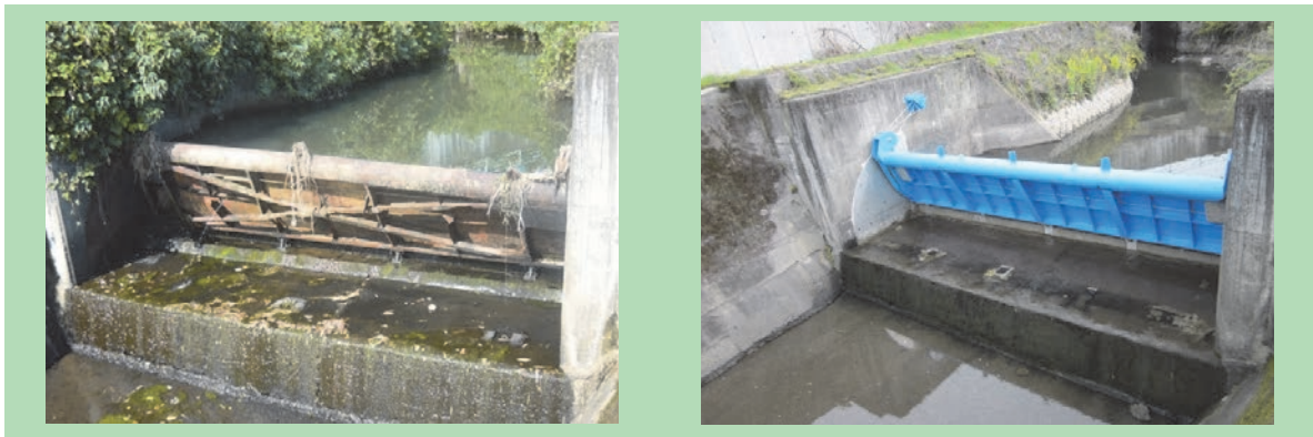
扉体の分解補修
