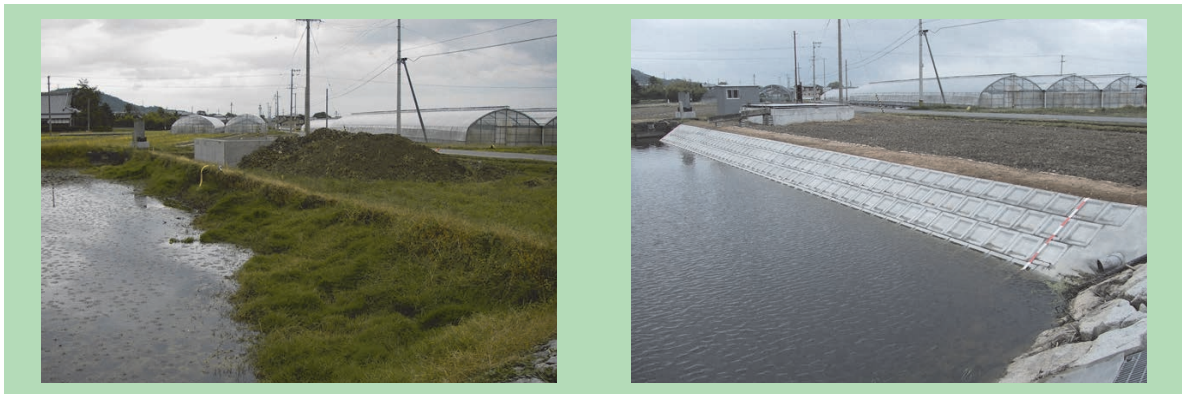
堤体(護岸)の補修
