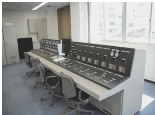
監視制御機器の更新
