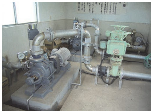
加圧ポンプの更新
