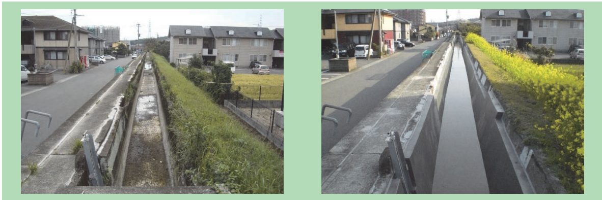
水路の目地補修及び表面被覆工
