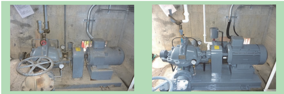
ポンプの整備補修、電動機交換
