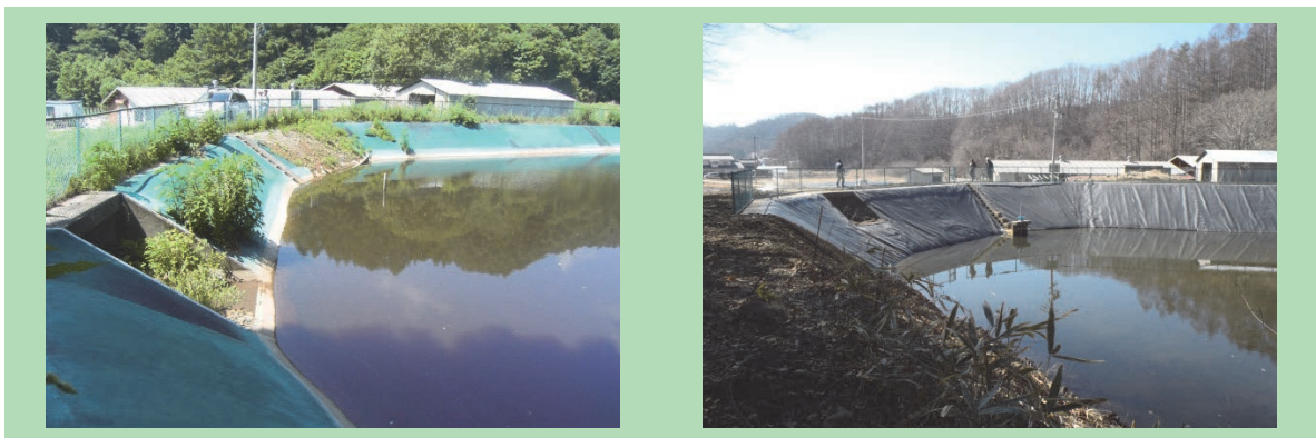
堤体・遮水シートの張り替え
