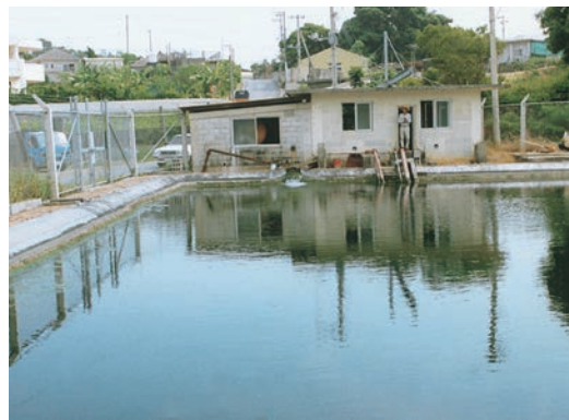
ファームポンド 漏水部の補修
