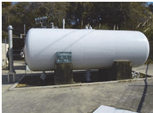
圧力タンクの補修、塗装
