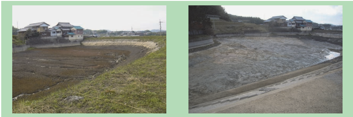
堆積土砂の浚渫
