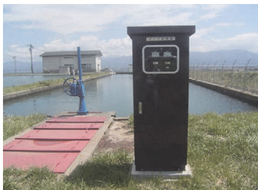
ポンプ制御盤の更新
