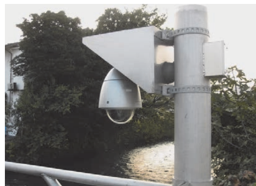
監視カメラの設置
