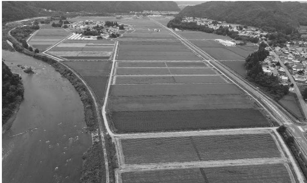
▲事業実施後ほ場全景
