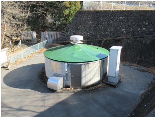
大間々頭首工 立坑
