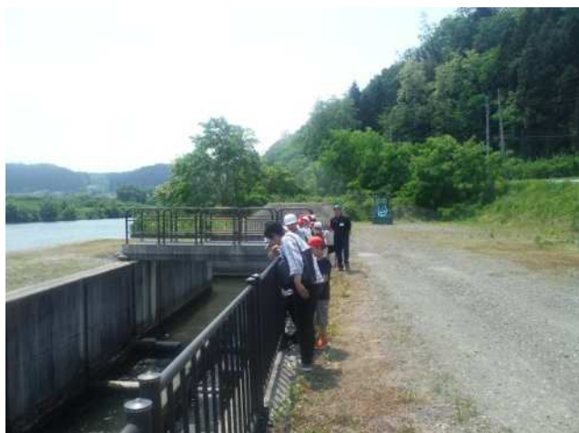
岩木川統合頭首工（魚道の見学・説明）
