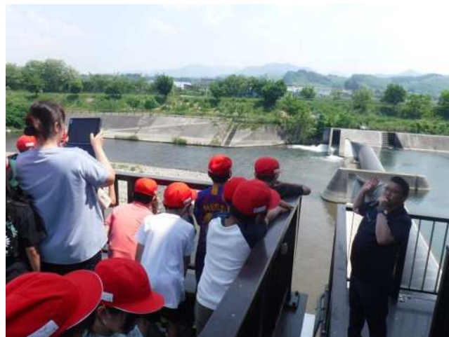
岩木川統合頭首工（ゴム堰の見学・説明）
