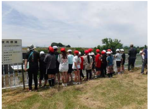
浅瀬石川第1頭首工を見学
