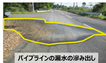
同じパイプラインにおいて連続して破裂
