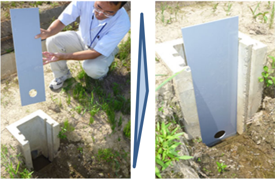
福井県鯖江市 田んぼダム事業（地域の約8割(1500ha)で実施） （左：調整板設置状況、右：排水柵（調整板挿入））
