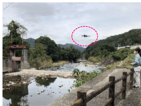
UAV（ドローン）による 頭首工の点検
