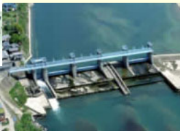
頭首工による安定・公平な取水
