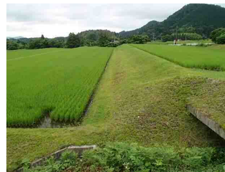
法面の緩傾斜化
