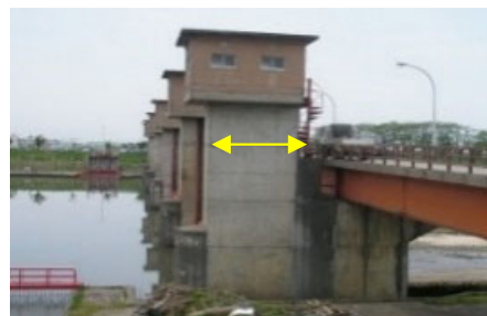
耐震化前の頭首工堰柱
