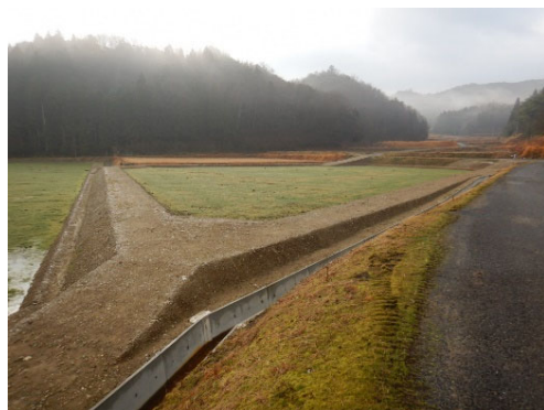
畦畔上でトラクタが作業できるように天端幅 2 m の畦畔を整備
