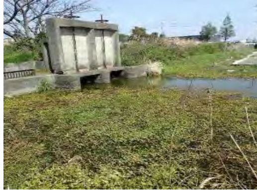
ナガエツルノゲイトウの繁茂による取水の阻害
