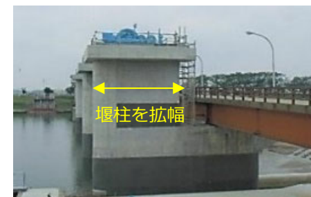
耐震化後の頭首工堰柱
