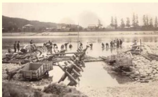
木製堰の築造風景
