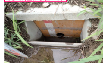
流出調整板設置の例
