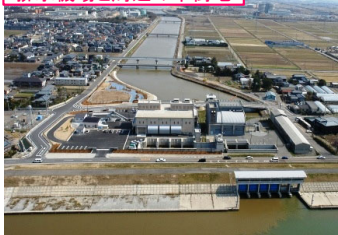
排水機場と周辺の市街地
