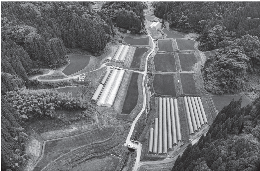
整備後の地区状況
