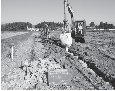
◀ 直営による 暗渠排水の 施工状況
