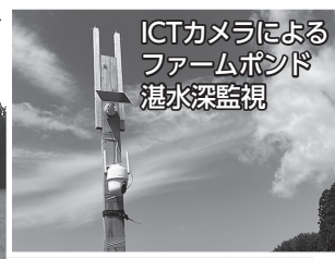
ICTカメラの活用▶
