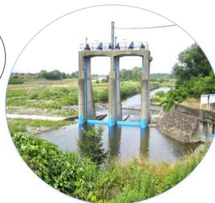
土砂吐ゲートには取水位調節・取水位確保・排砂・洪水流下等の機能があることを説明しました。
