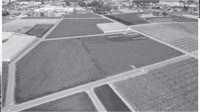
▼大区画化ほ場整備
