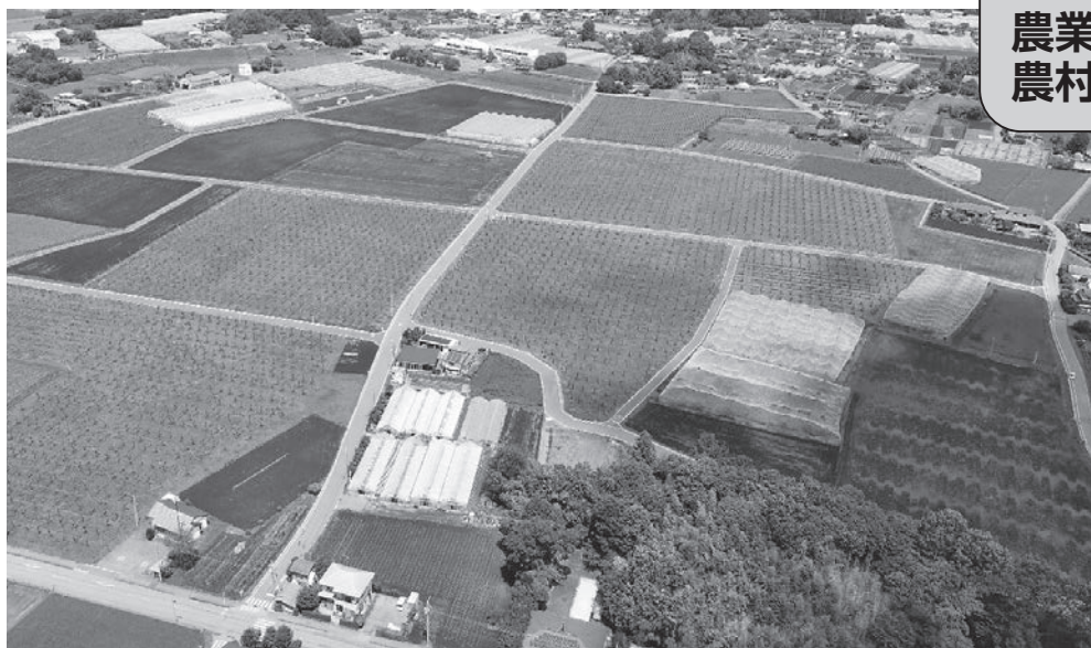
整備後の地区全景
