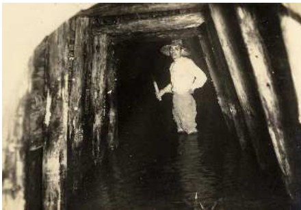
トンネル工事の様子
