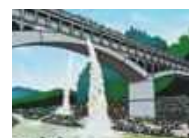
D 左岸連絡水路橋
