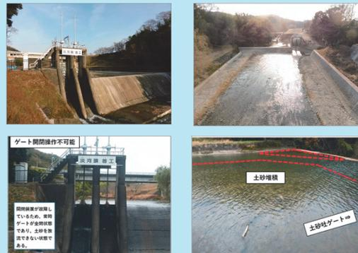
○豪雨時に頭首工の土砂吐ゲートの未作動などで、周辺地域へ浸水などの被害が出る恐れがあります。ゲート整備や浚渫などの整備を行い、被害を未然に防止する役割を担います。
