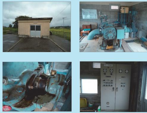
○揚水機場の電動機が古い場合、作動効率の低下や電気料金がよくかかる場合があります。整備により電動機を高効率化し、維持管理費の低減を図ります。
