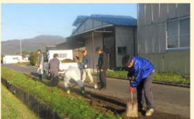
農道の補修作業。
