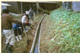
水路の簡易補修作業。
