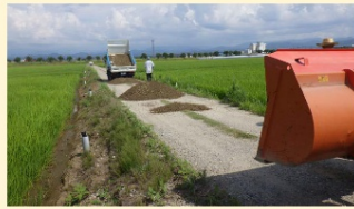
(上) 糠に砂利を補充して路面を維持。交付金を活用することで油圧ショベルなどの大型重機も借りやすくなった。 (下) 畦道やため池周辺などの草刈り。
