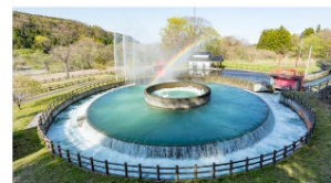
(右上)水路補修の仕上げは農家の共同作業。(右下)農地の一部は実習田として地元の小学生に開放している。(上)改良区内の水路に水を配分して送る「円筒分土工」は国内最大級の規模。
