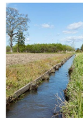
板橋で補修した水路。
