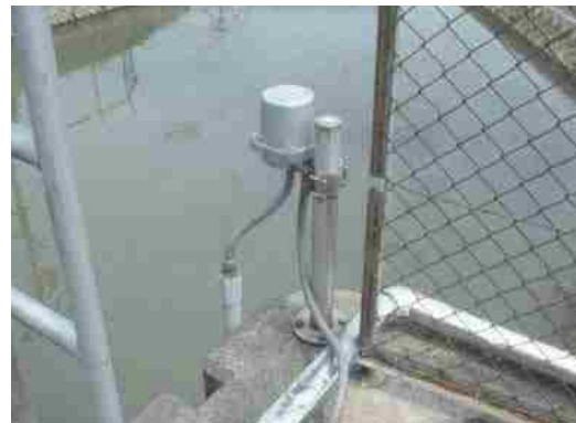
水位計測器の更新
