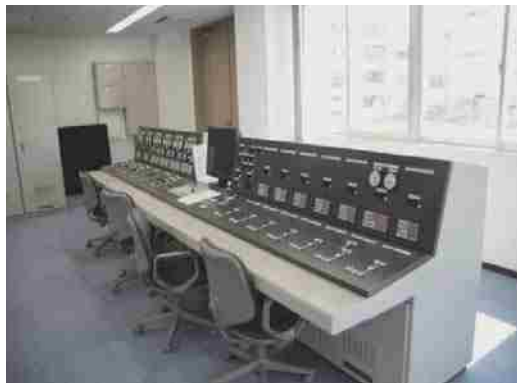
監視制御機器の更新
