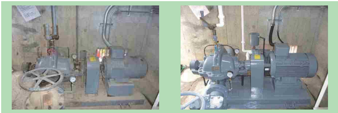
ポンプの整備補修、電動機交換
