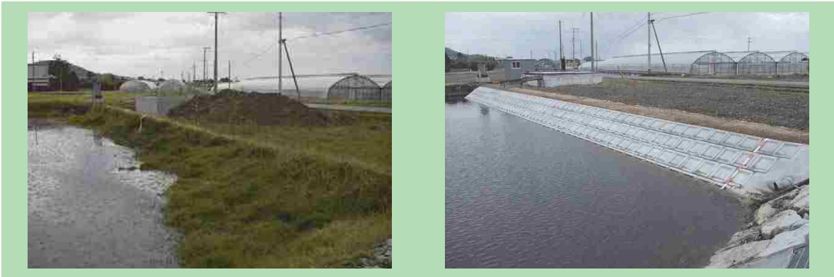
堤体(護岸)の補修
