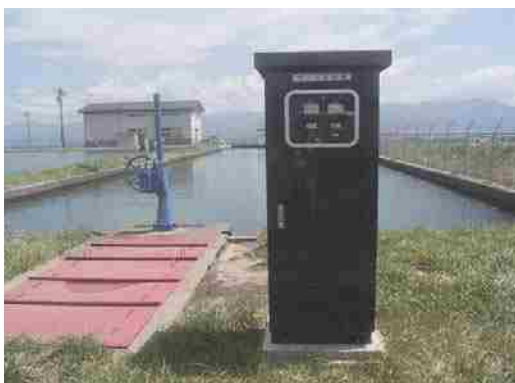
ポンプ制御盤の更新
