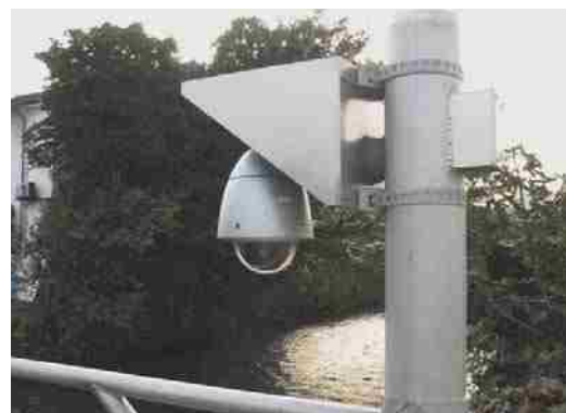
監視カメラの設置
