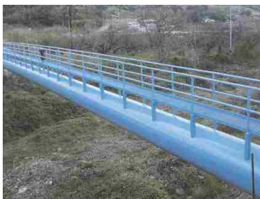
管水路 (水管橋) の補修・塗装
