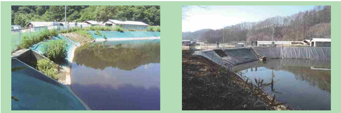
堤体・遮水シートの張り替え
