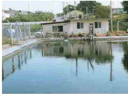
ファームポンド 漏水部の補修
