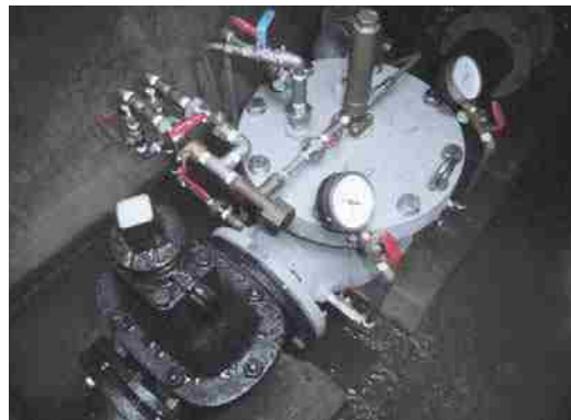
減圧弁の補修
