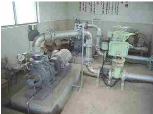
加圧ポンプの更新
