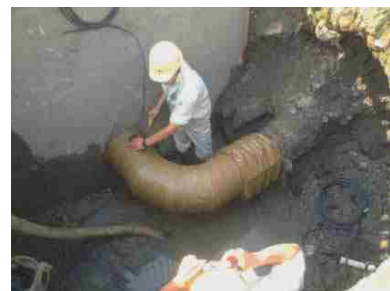
管水路 (漏水箇所) の補修
