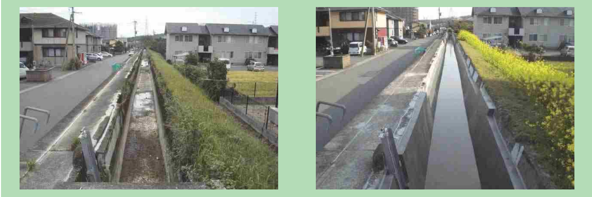
水路の目地補修及び表面被覆工
