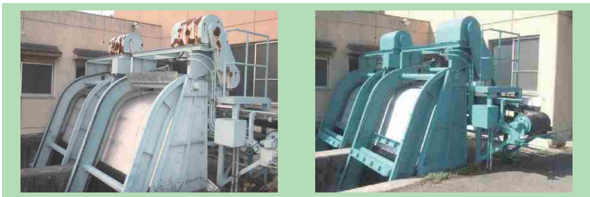
除塵装置の分解補修、塗装
