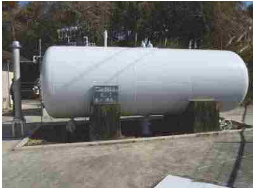
圧力タンクの補修、塗装
