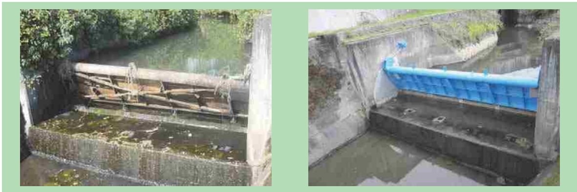
扉体の分解補修
