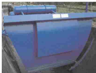
分水工 (水位調整ゲート) の塗装
