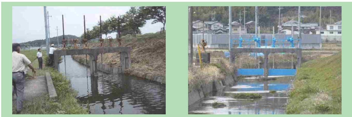
巻上機の整備補修
