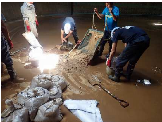
③スケール搬出作業
