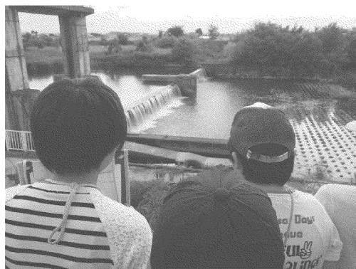
頭首工の原理にびっくり！！ (水土里ネット南旭川：上堰頭首工)
