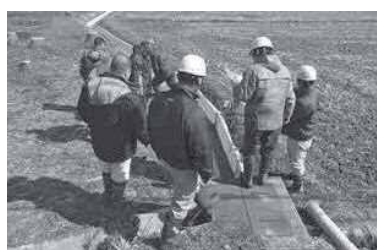
長寿命化対策で更新した水路を活動組織と共に現地確認
