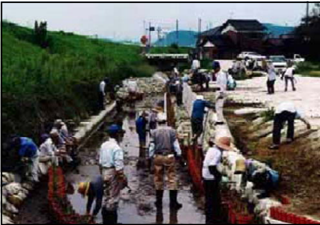
住民の手による集落排水路への水性植物の植栽
