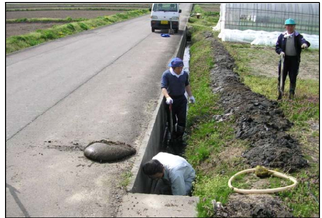
水路堰上げ作業
