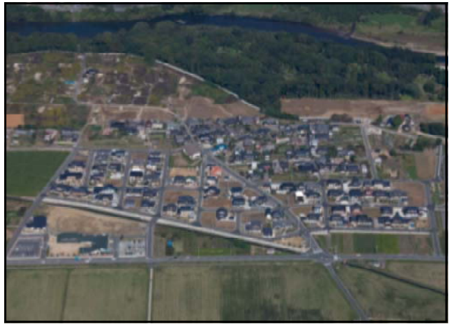
由良川改修による戸田集落の移転先用地を確保
