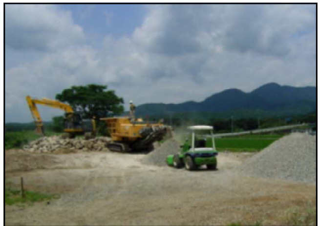
現場発生コンクリートを破碎し、 農道砂利舗装に再利用
