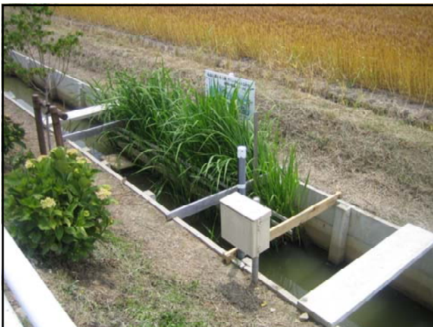
マコモU字溝の設置
