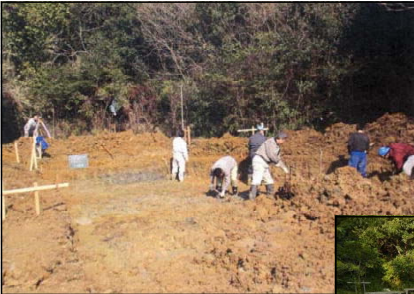
地元住民参加の直営施工によるビオトープの設置
