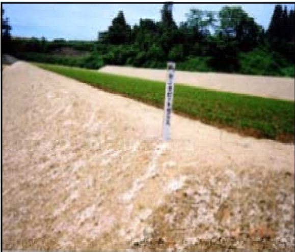
水田法面へのカバープランツ植栽
