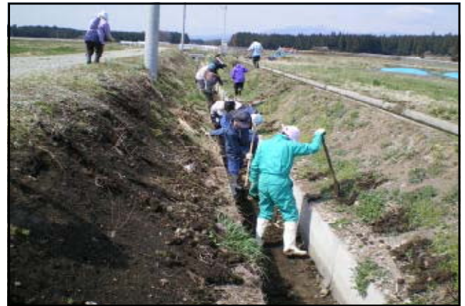
地区の環境を守る水路の清掃
