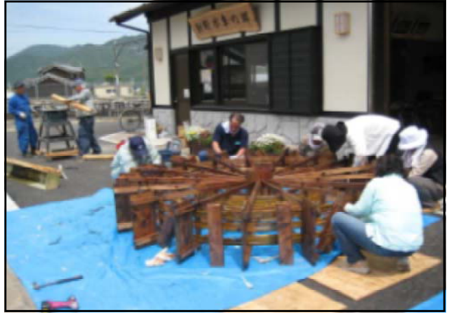
水車の補修（直営施工）
