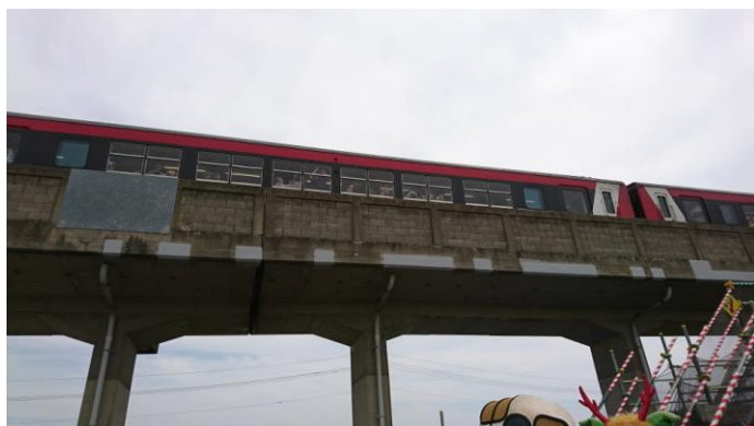
停車する列車の車窓から田んぼアートを撮影する人
