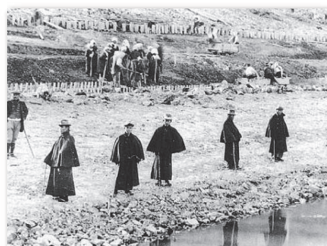
1883年の入鹿池工事
