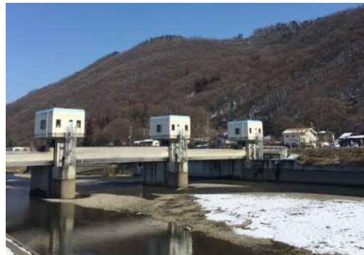
奈良井川から取水する拾ヶ堰頭首工
