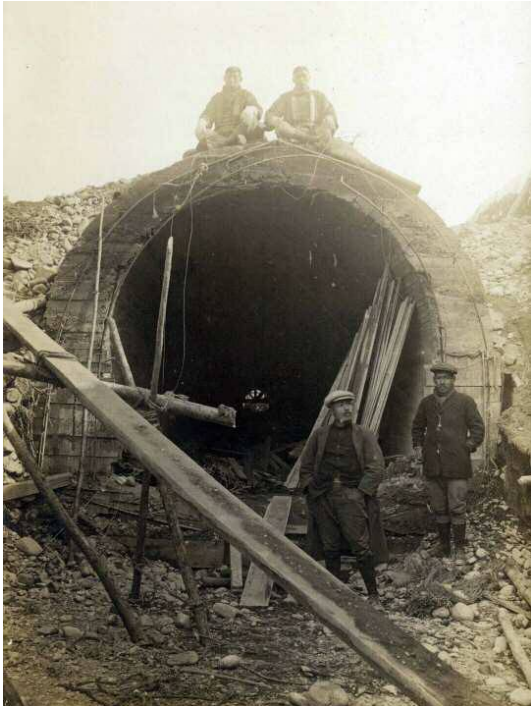
河川横断部を平面横断からサイフォンに改修した当時の写真（大正9年）
