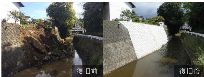
平成28年（2016年）の熊本地震により 被災した用水路（上井手用水）
