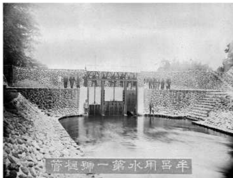
牟呂松原幹線には人造石工法部分が残存
