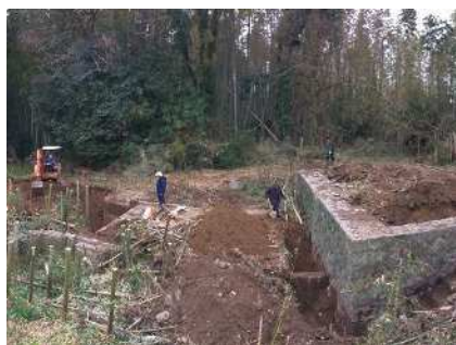
旧取水口樋門発掘の様子
