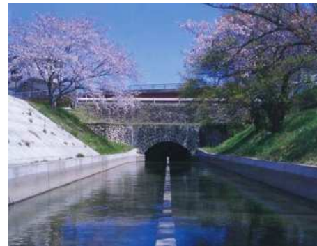
牟呂松原幹線には人造石工法部分が残存
