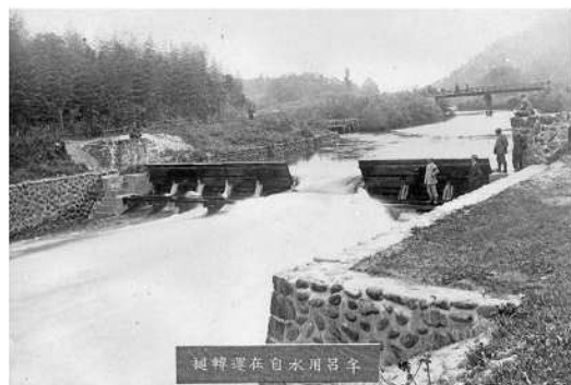
自在運転樋（牟呂用水）
