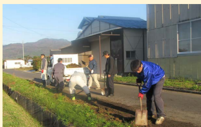
農道の補修作業。
