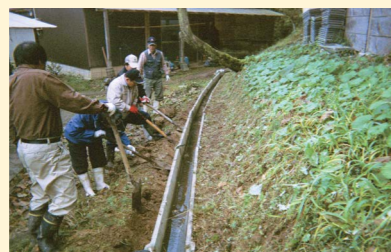
水路の簡易補修作業。
