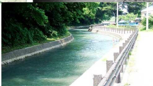
昭和初期（上）と現在（下）の北楯大堰
