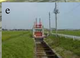
大石ゲートポンプ
