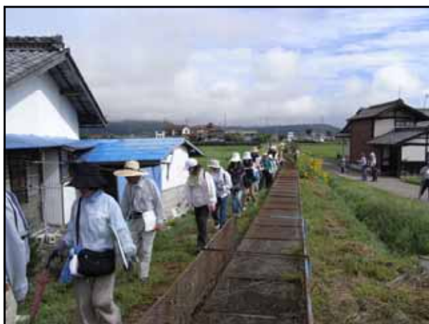
つきせぎ（盛土により水路の高さを確保している）沿いを歩く
