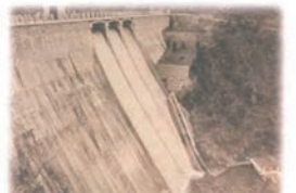
山田川疏水山田池堰堤
