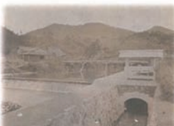
山田川疏水水源堰堤全景
