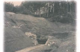
淡河川疏水二十番(芥子山)隧道鉄管入口
