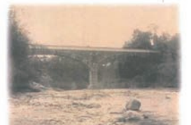
淡河川疏水御坂噴水管架載志染川弧石橋
