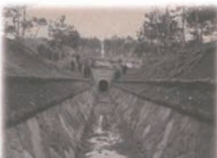
山田川疏水第十九号隧道口
