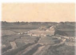
淡河川疏水練部屋排水閘
