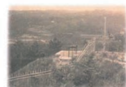
淡河川疏水御坂噴水管敷設
