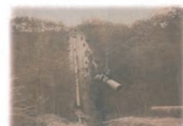
山田川疏水岩岡支線鉄管サイフォン
