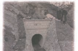
山田川疏水第二号隧道
