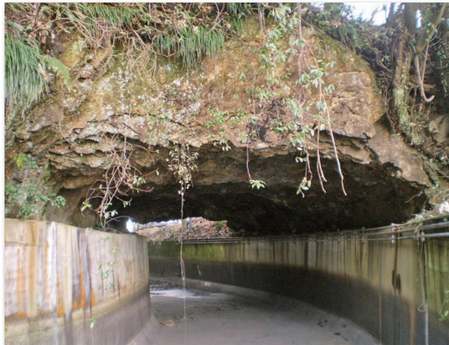
岩盤掘削の痕跡
