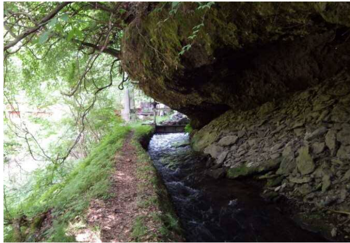
岩をくりぬいた水路（滝之湯堰）
