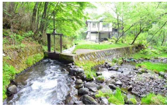
下流域への水も確保するため、あえて漏水する構造の芝湛（しばたたえ）（大河原堰の取水口）
