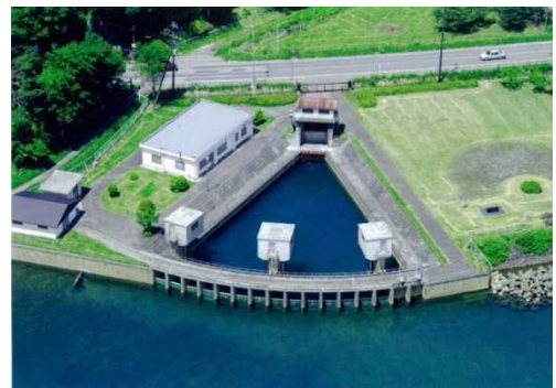
現在の取水口【上戸頭首工】
