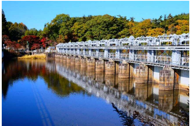
現在の十六橋水門
