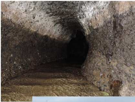
宝永隧道内部
