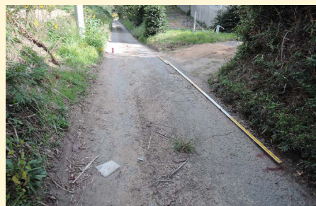
水兼道路の補修作業。ひび割れた路面などを補修。
