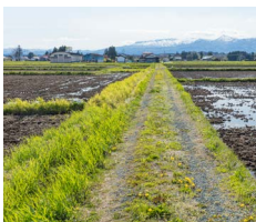
(上)未補修の農道。(下)轍を直し、敷き砂利をすることで大型の農業機械も安全に通行できるようになる。
