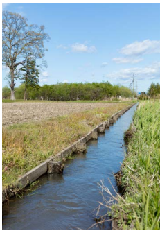
板柵で補修した水路。
